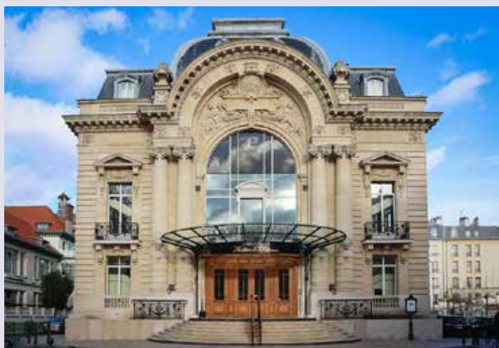
Façade du Théâtre de Puteaux, photographie, 2017, service Communication.
