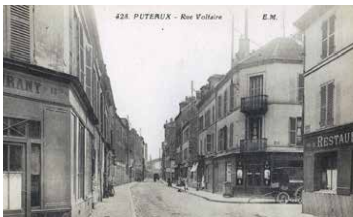
Puteaux, rue Voltaire depuis le croisement avec la rue du 8 Mai 1945 (à droite, la rue Pitois), carte postale, début du XX e siècle, AMP, 2Fi146.
