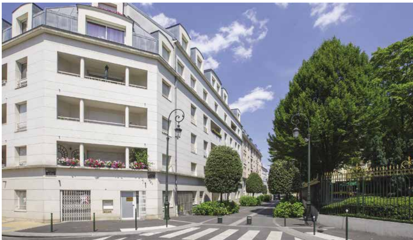
Rue de l'Appel du 18 juin, photographie, 2017, service Communication.
