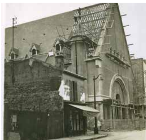
L'église Sainte-Mathilde lors de sa construction, photographie, 1933-1934, AMP.
