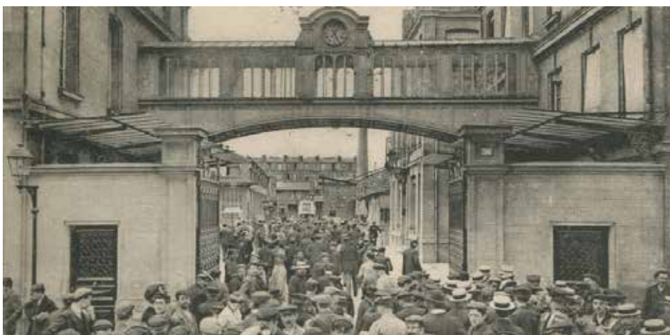
Puteaux, Usine De Dion-Bouton, la rentrée des ouvriers, carte postale, début du XX e siècle, AMP, 2Fi2191.
