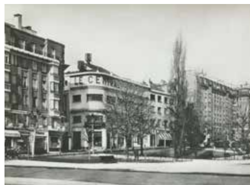
L'ancien cinéma «Le Central», à l'angle des rues Chantecoq et Lucien Voilin qui a fonctionné de 1934 à 1973, carte postale, mi-XX e siècle, AMP, 2Fi1878.
