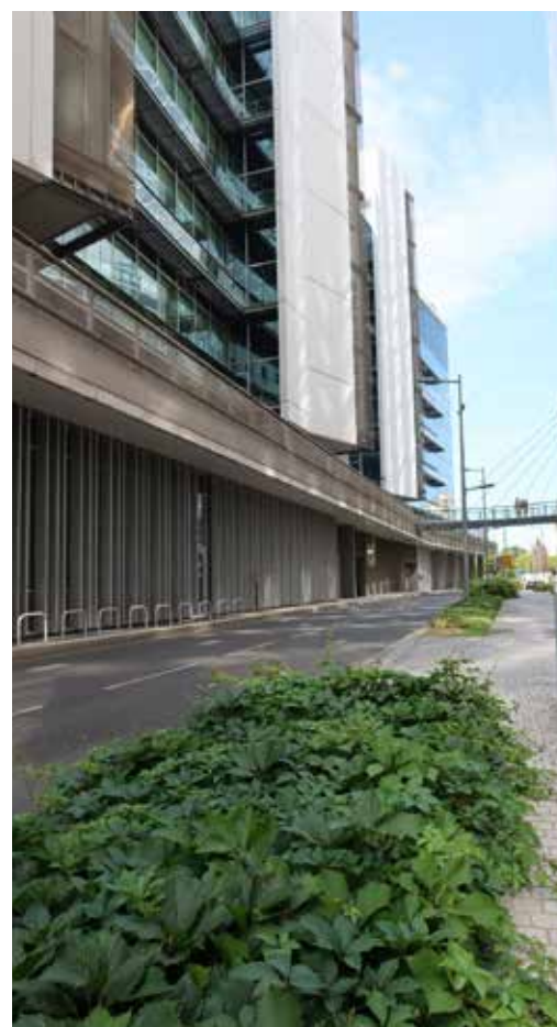
Boulevard des Bouvets, photographie, 2022, service Communication.
