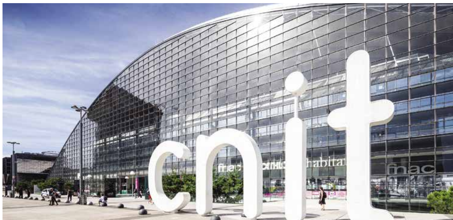
Le Palais du Centre National des Industries et Techniques, photographie, 2025.
