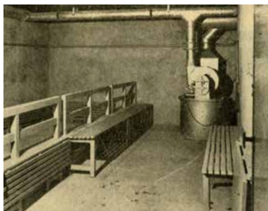
Les abris de Puteaux, photographie, 1939, bulletin municipal, 1939, AMP.
