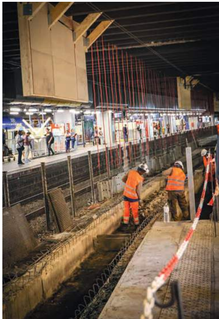
Les travaux en cours au niveau du tram T2 à La Défense
