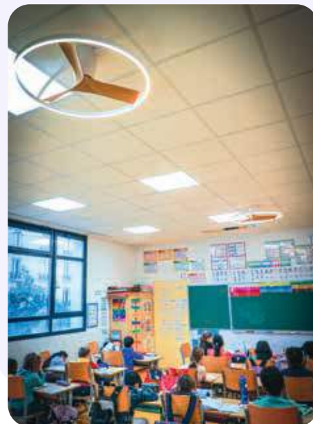
Des travaux ont eu lieu dans les écoles dont l'installation de ventilateurs
