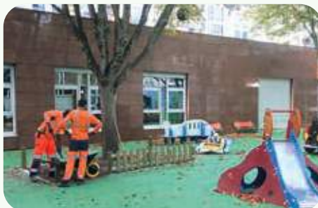
Travaux de la cour oasis Pyramide maternelle
