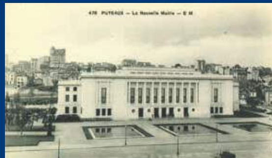
Puteaux, la nouvelle mairie, vue façade coté esplanade avec les trois bassins, carte postale, années 1930-1940, AMP, 2Fi325
