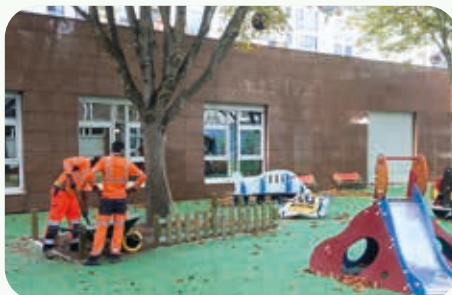
Travaux de la cour oasis Pyramide maternelle
