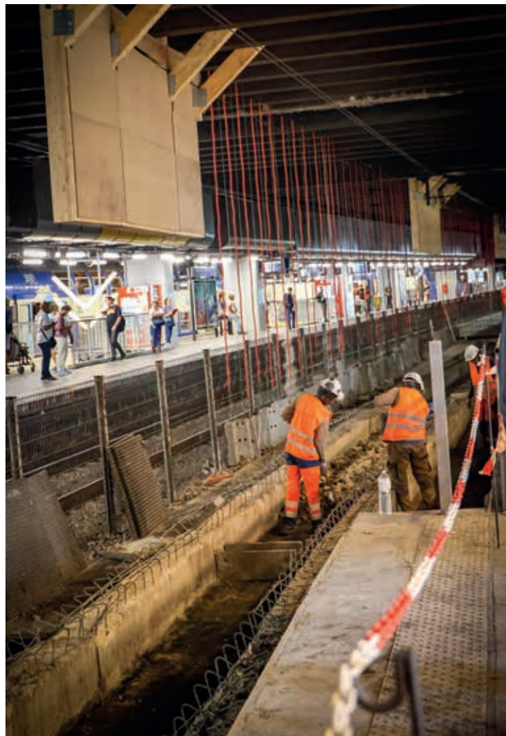
Les travaux en cours au niveau du tram T2 à La Défense
