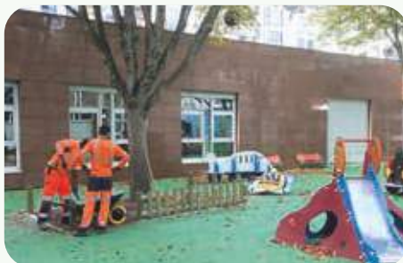
Travaux de la cour oasis Pyramide maternelle
