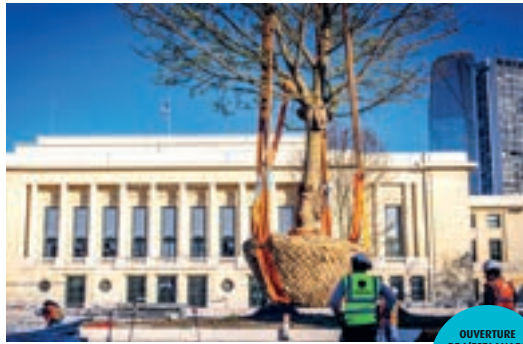
Une attention toute particulière a été apportée, afin de ne pas endommager les racines des arbres
