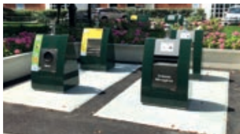
Conteneur enterré pour les déchets ménagers
