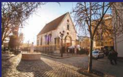
Rénovation de l'église Notre-Dame-de-Pitié
