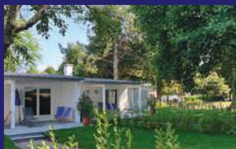
Rénovation et extension des bungalows de Plœmeur
