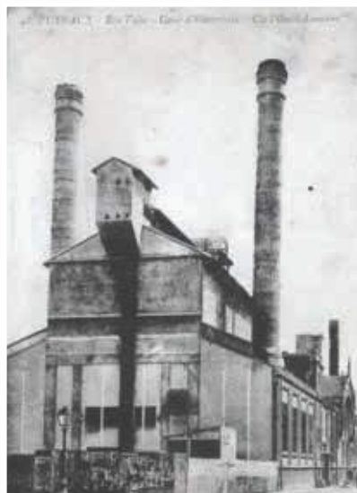
L'Usine d'électricité « Cie Ouest-Lumière » rue Volta, carte postale, début XXe siècle, AMP 2Fi619
