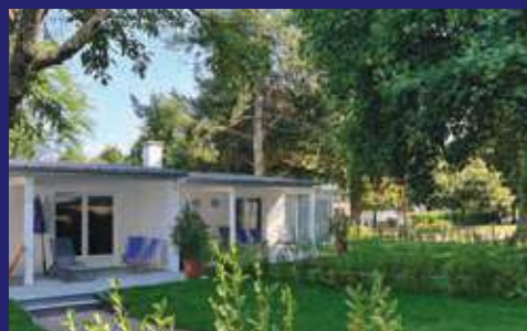
Rénovation et extension des bungalows de Plœmeur
