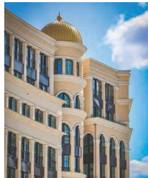
Le 14, avenue des Bergères accueillera l'IFPASS en août 2026
