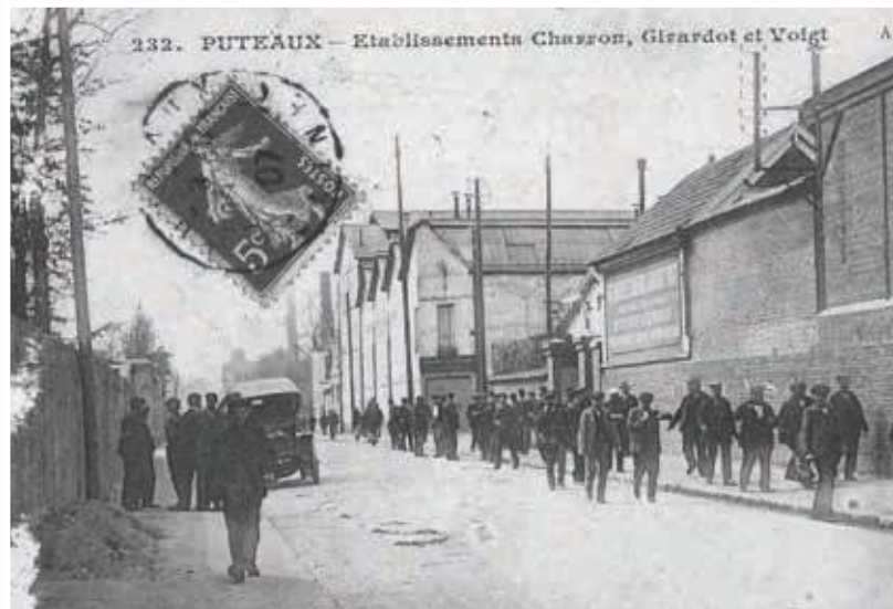
Les établissements Charron, Girardot et Voigt et les usines Morane-Saulnier rue Ampère, carte postale, début XXe siècle, AMP 2Fi531.
