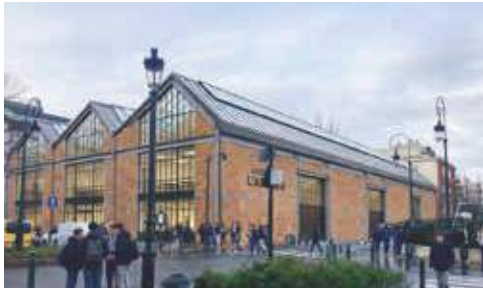
Création d'un lycée privé rue Volta*
