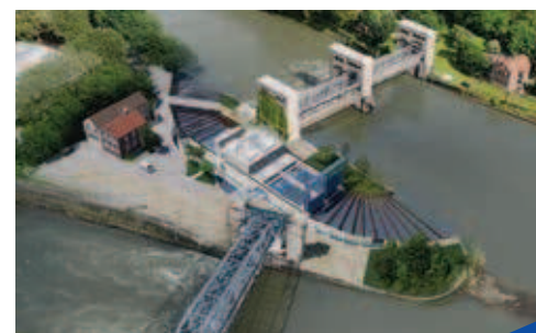
Barrage hydraulique nouvelle génération*
