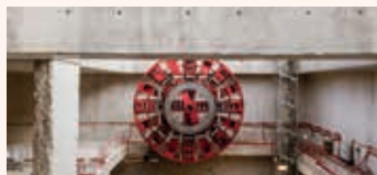
Tunnelier de la ligne 15
