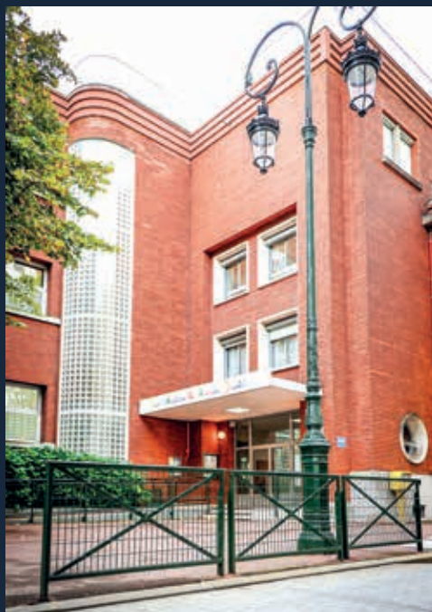
Construit entre 1933 et 1938, le groupe scolaire Jacotot adopte les formes géométriques du style Art déco
