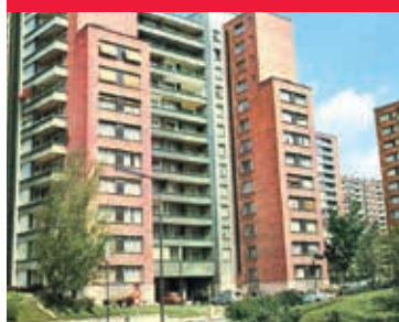
La résidence HLM Lorilleux depuis l'avenue du Président-Wilson en 1987 (aujourd'hui avenue du Général-de-Gaulle) - 2Fi1561, AMP
