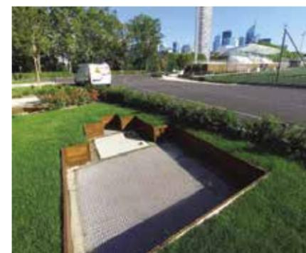
Cuve de récupération des eaux pluviales sur l'Île de Puteaux de 400 m<sup>3</sup>
