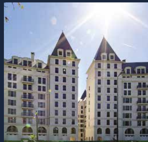
Arrivée des premiers habitants aux Bergères
