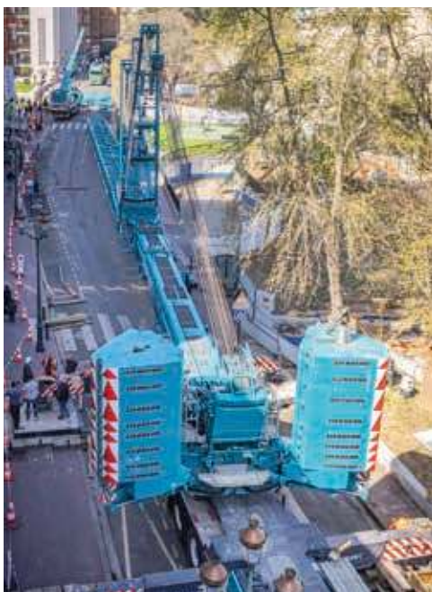
Une flèche de 90 m de portée installée sur une grue de 450 tonnes et haute de 110 m ont été nécessaires à l'installation de 5 arbres centenaires (4 érables, dont 2 en cépée multitronc et 1 chêne en cépée de 2 troncs). Pour cette opération, le terrassement de l'Esplanade a été protégé
