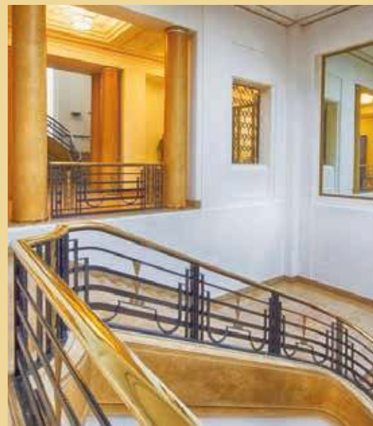
Ferronneries des escaliers d'honneur réalisées par Raymond Subes
