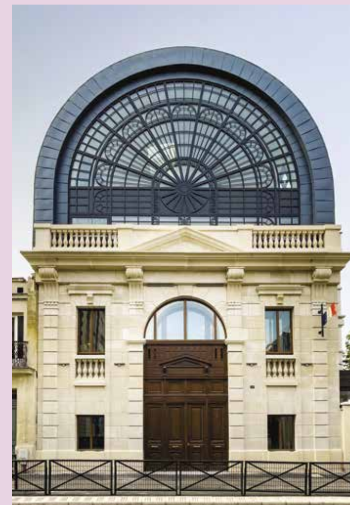
L'entrée de l'école rue Parmentier, conservant la façade de l'ancien Casino. Le bâtiment est coiffé d'une verrière abritant la bibliothèque
