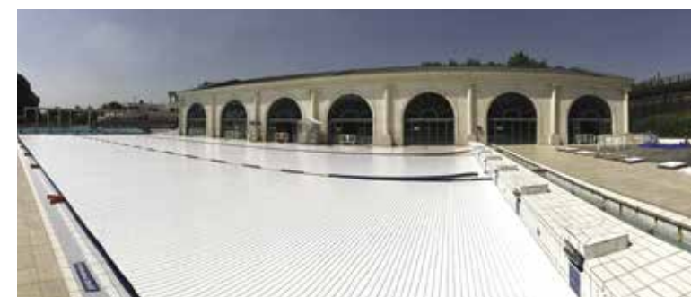
Bâche thermique de la piscine du Palais des Sports
