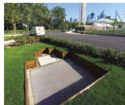
Cuve de récupération des eaux pluviales sur l'Île de Puteaux de 400 m 3
