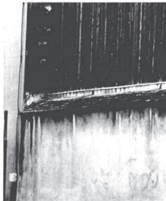
Les murets sont généralement composés d'un murs bahut d'une hauteur avoisinant 1,20m, surmontés de grilles munies de pointes et parfois de festonnage.
