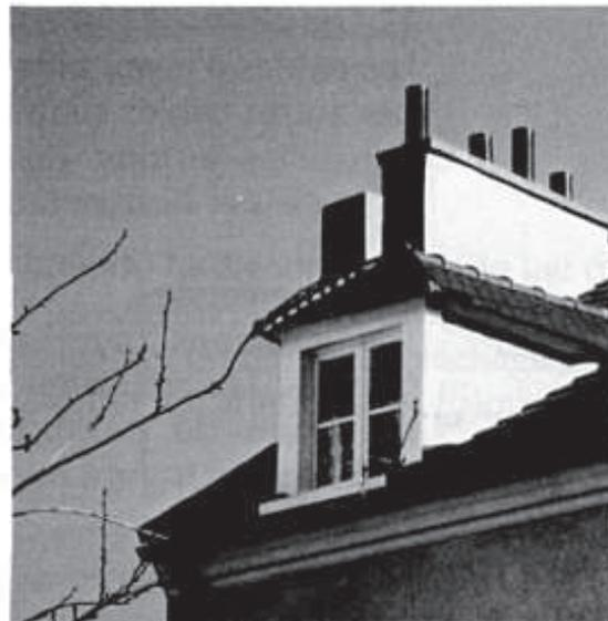
Il est recommandé de conserver les souches de cheminées qui sont indispensables au profil des faîtages. Elles peuvent servir de conduits de ventilation et, si elles doivent être abandonnées, seront simplement bouchées au niveau des mitrons. Les sorties de conduits en béton préfabriqué sont à éviter, de même que les entablements trop débordants et minces. Le contour des cheminées participent à la typologie des immeubles.
