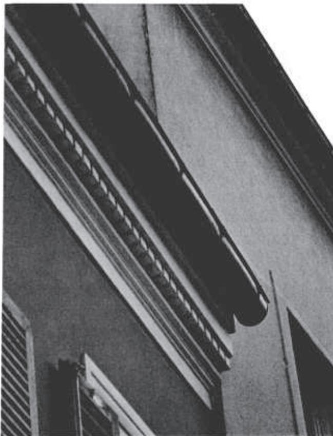
Les profils en aggro de ciment sont très simples et mal adaptés aux maisons anciennes. Ils n'ont en général qu'une fonction décorative et ne font pas rejet d'eau. Ils sont utilisés dans des maçonneries en parpaings de ciment, pour donner un style néoclassique.
