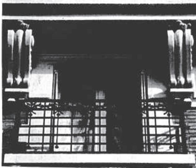
Leur ferronnerie, exécutée en fonte coulée, offre un remplissage de plein par rapport au vide assez important. Il faudra tenter de les restaurer, et si cela n'est pas possible, de les remplacer par des modèles de récupération de même style.
