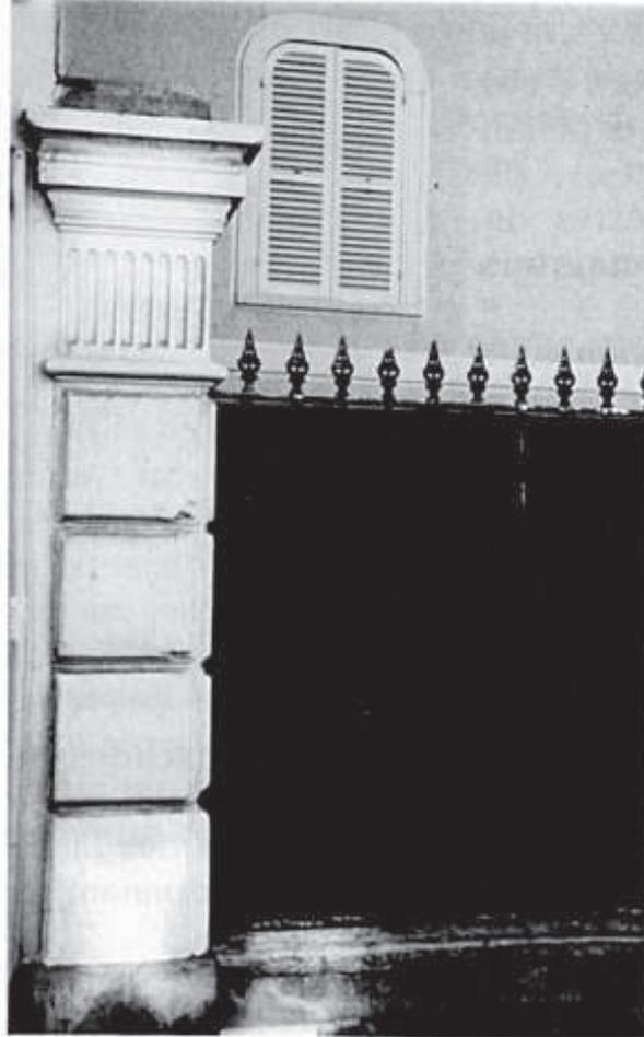
Lorsque les murets sont construits en meulière, il est recommandé de refaire le jointoiement et de laisser le matériau de construction apparent. Dans les autres cas de figure, il faut refaire un enduit adapté au support. Comme pour le pied des façades, il est recommandé de réaliser un soubassement. Les grilles seront pour leur part réparées et leurs éléments manquants réassortis.
