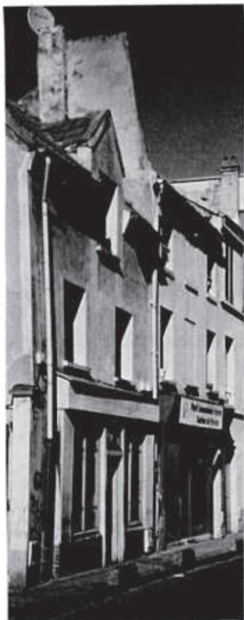
La règle était la cheminée en pignon débouchant dans le tiers haut du rampant de toiture. Le conduit réalisé soit dans l'épaisseur du mur, soit en boisseaux accolés, était enduit au plâtre dans sa partie extérieure. Le conduit se terminait par des mitrons en terre cuite. Les conduits anciens étaient assez massifs.
