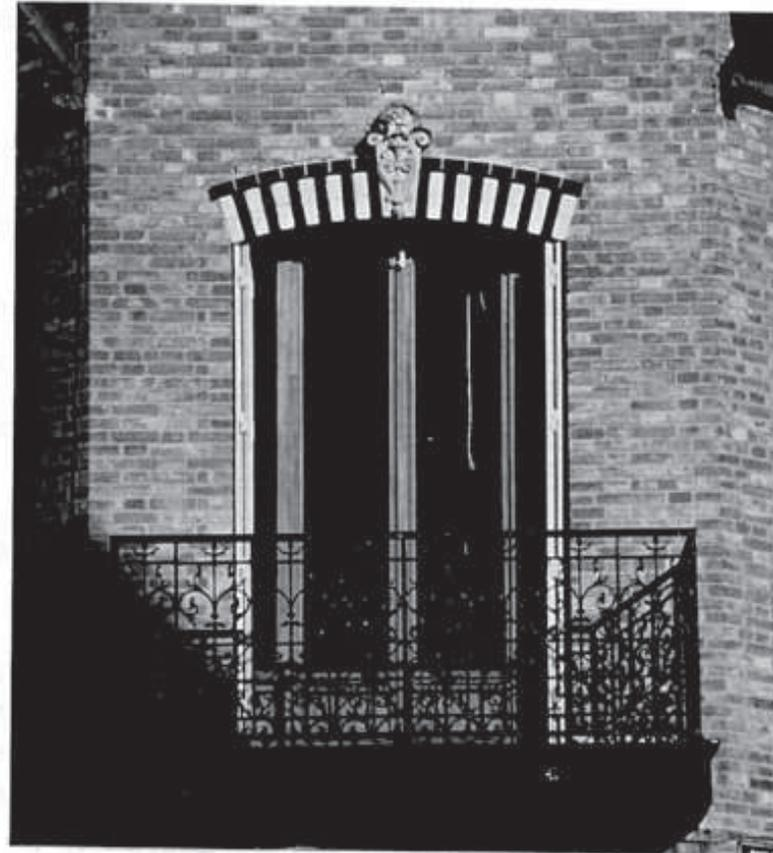
l'ancien bâti pour y rapporter un bâti neuf à l'intérieur. Cela permet de ne pas avoir à refaire de scellements ni de reprises intérieures. Cette mise en oeuvre diminue beaucoup les surfaces vitrées au détriment des épaisseurs des encadrements. Le rapport plein/vide se modifie, nuisant à l'esthétique. Il peut en résulter une perte d'éclairage pour les pièces d'habitation aggravant ainsi l'insalubrité des pièces.
