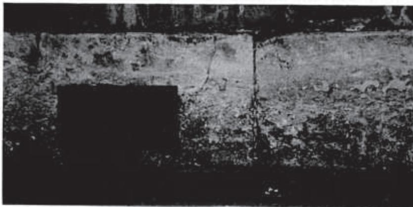
Elles n'étaient pas liées sur les moellons par un ciment, mais étaient stabilisées par un mortier très pauvre comprenant beaucoup de sable. Le reste du ravalement était exécuté au plâtre gros ou à la chaux. Simples, esthétiques, conçus à une époque où les rues n'étaient pas encore pavées, ces soubassements, en dalles brutes, sont parfaitement adaptés à l'humidité du terrain. Il est possible de les découvrir à l'occasion du piochage d'un enduit ciment.
