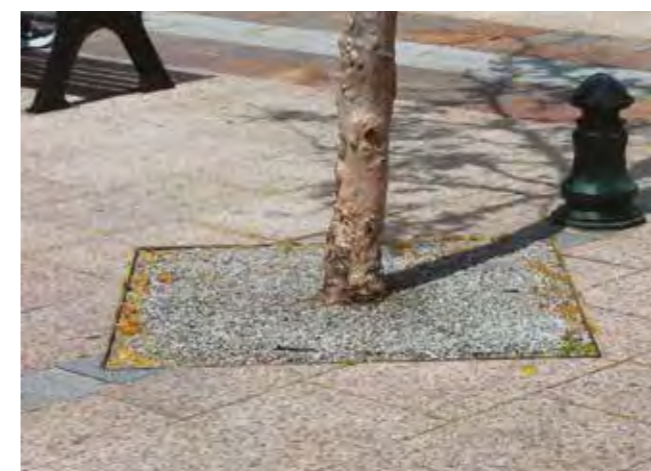
Un pied d'arbre imperméabilisé
