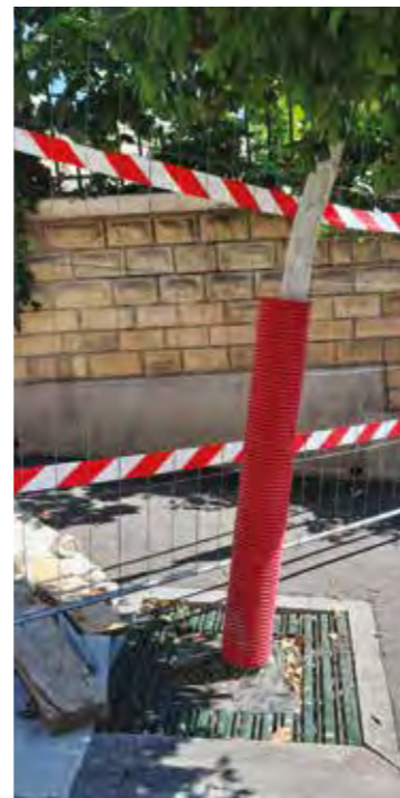
Arbre protégé pour un chantier
