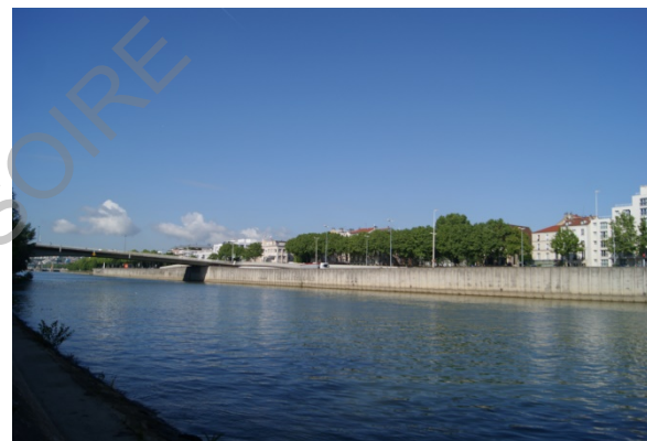
Berges urbaines de la RD 7 (Source : Mediaterre conseil, mai 2015)
