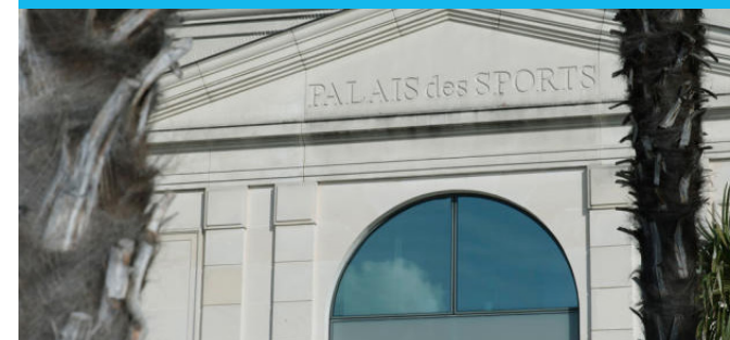
Accessibilité hall d'accueil du Palais des sports
